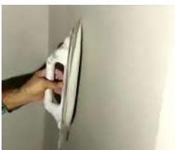
9. Stendere una sottile mano di rasante di finitura con una spatola liscia e passare con frattazzo per lisciare e lasciare asciugare completamente.
