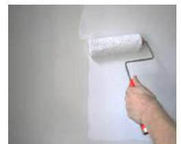
10. Rfinire con stesura di due mani di pittura traspirante a base silicati di potassio o a base calce.
