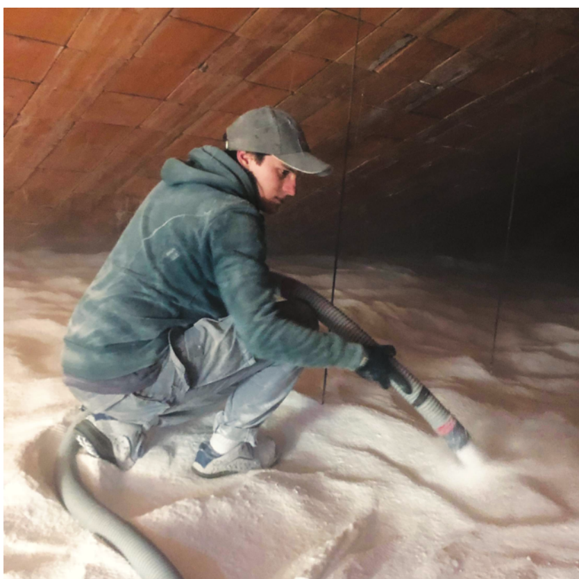
Insufflaggio sottotetto
