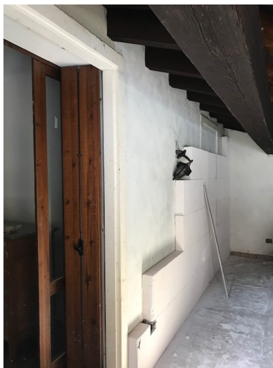
Posa di pannelli a parete
