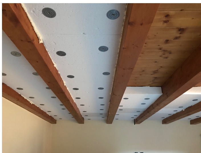
Posa di pannelli a soffitto
